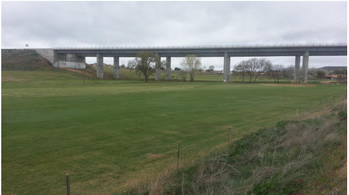
Foto 3.- Aspecto de la zona destinada al campo de golf. Viaducto
